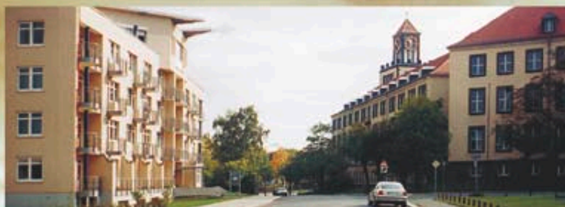
Gästehaus AM WEBERPLATZ ★★★ Weberplatz 3, 81217 Dresden Telefon: 0351/ 467 93 00 Telefax: 0351/ 4 67 93 94
